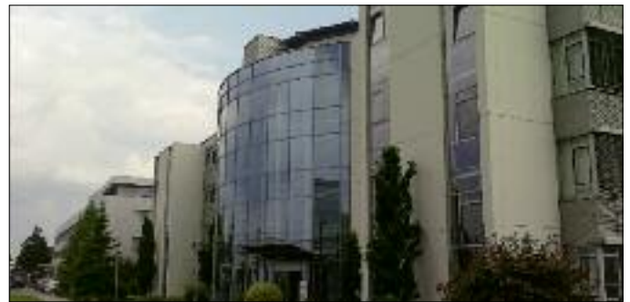
Bereich Zentrale PKW in Dielingen: Rund 600 Umzüge hat es hier in der letzten Zeit gegeben.
