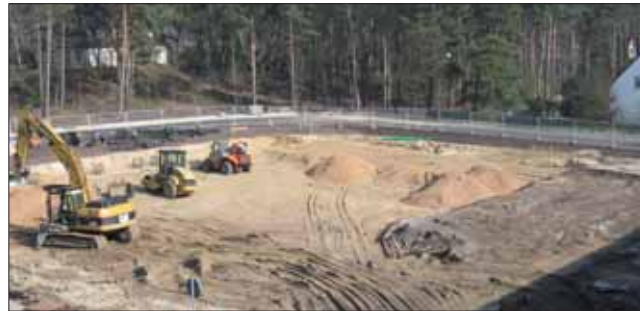
Sichtbares Zeichen für den Aufschwung: die Baustelle für die neue Logistikhalle im Werk Wagenfeld.
