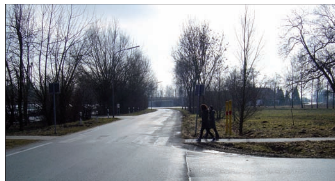
Gefahrenquelle am Zebrastrifen: Der Übergang ist nur schlecht ausgeleuchtet. Die Straßenleuchte an der Straßeneinmündung zum Parkplatz hinten links reicht nicht aus.
